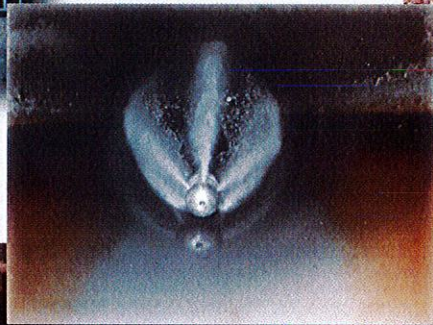
▲ 管内洗浄作業
