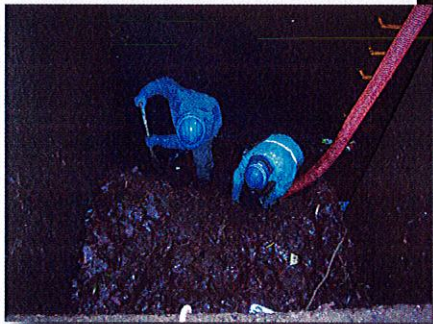
▲ 雨水伏越清掃作業
