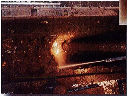
▲ 側溝清掃作業
